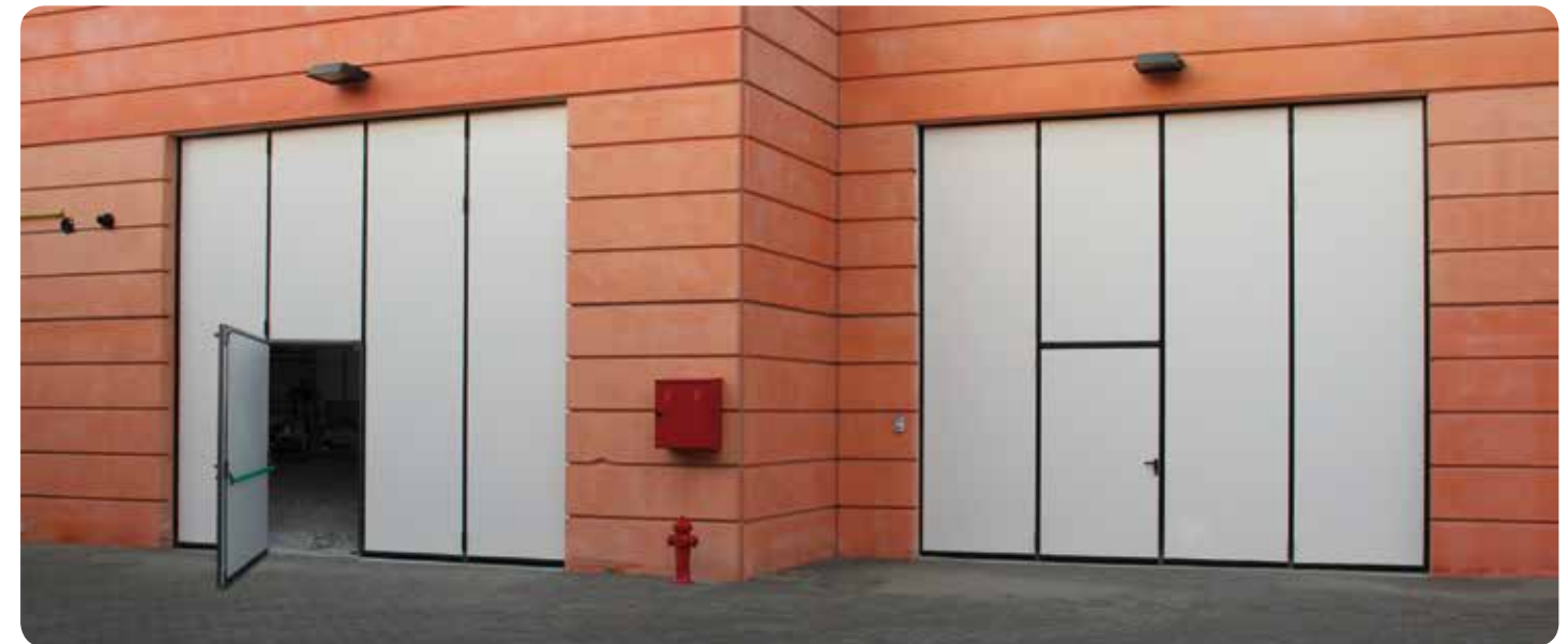
ANTA TAGLIATA REALIZZATA SU ANTE CENTRALI DEL PORTONE CON MANIGLIONE ANTIPANICO
